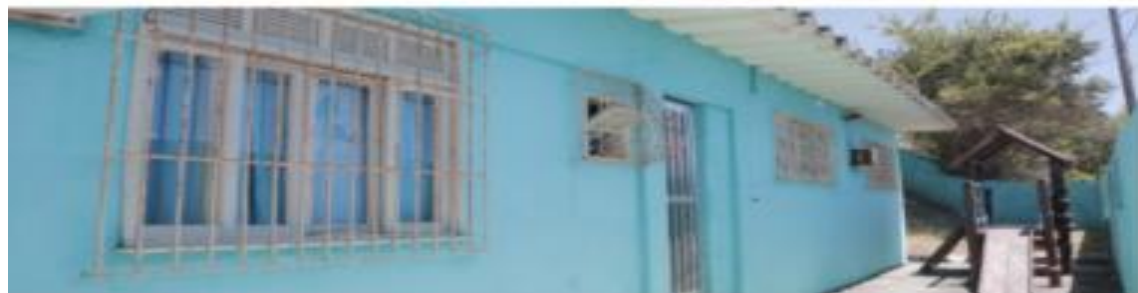
Reforma e Ampliação da E. M. Elizio Ignácio Rangel - Baleia
